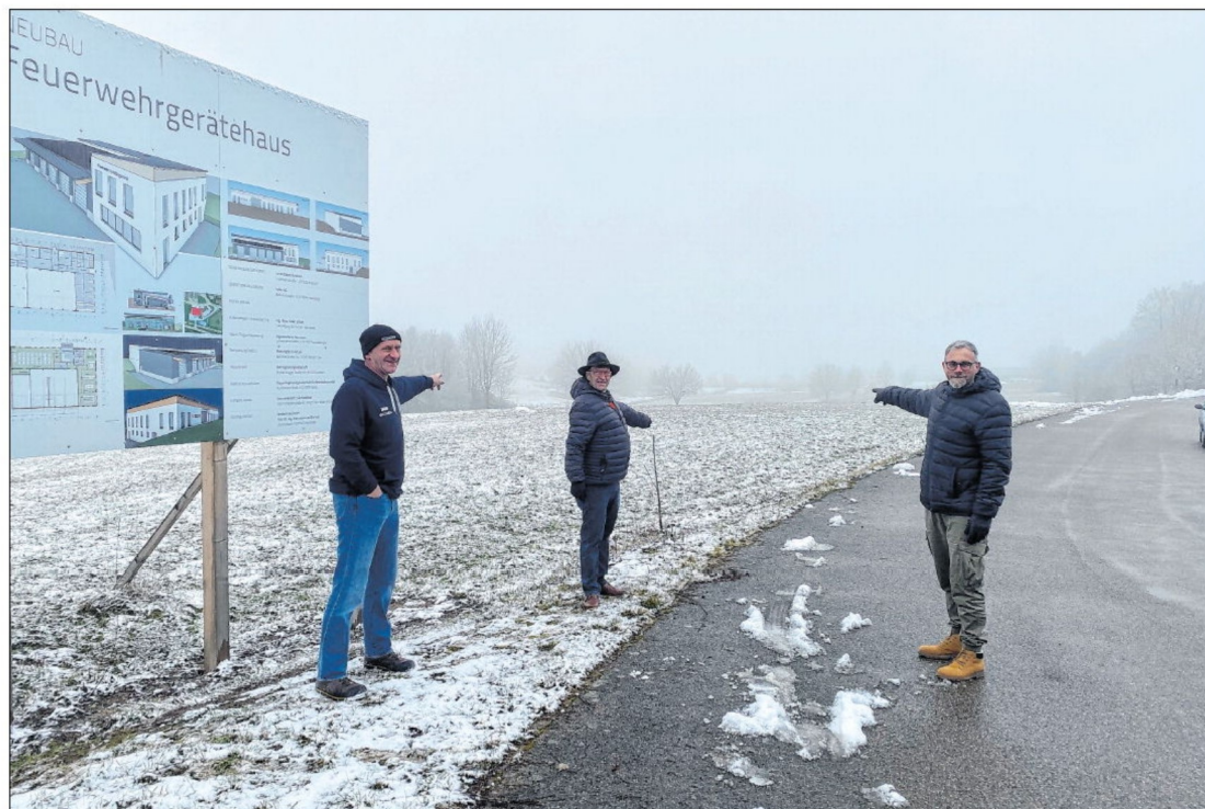
Da kommt es hin: Bürgermeister Michael Trzybinski (Mitte) und die beiden Kommandanten der Schillingsfürster Feuerwehr, Holger Spang (links) und Stefan Sterner, trafen sich zum Termin am Bauplatz des neuen Feuerwehrgerätehauses. Foto: Volker Raab
